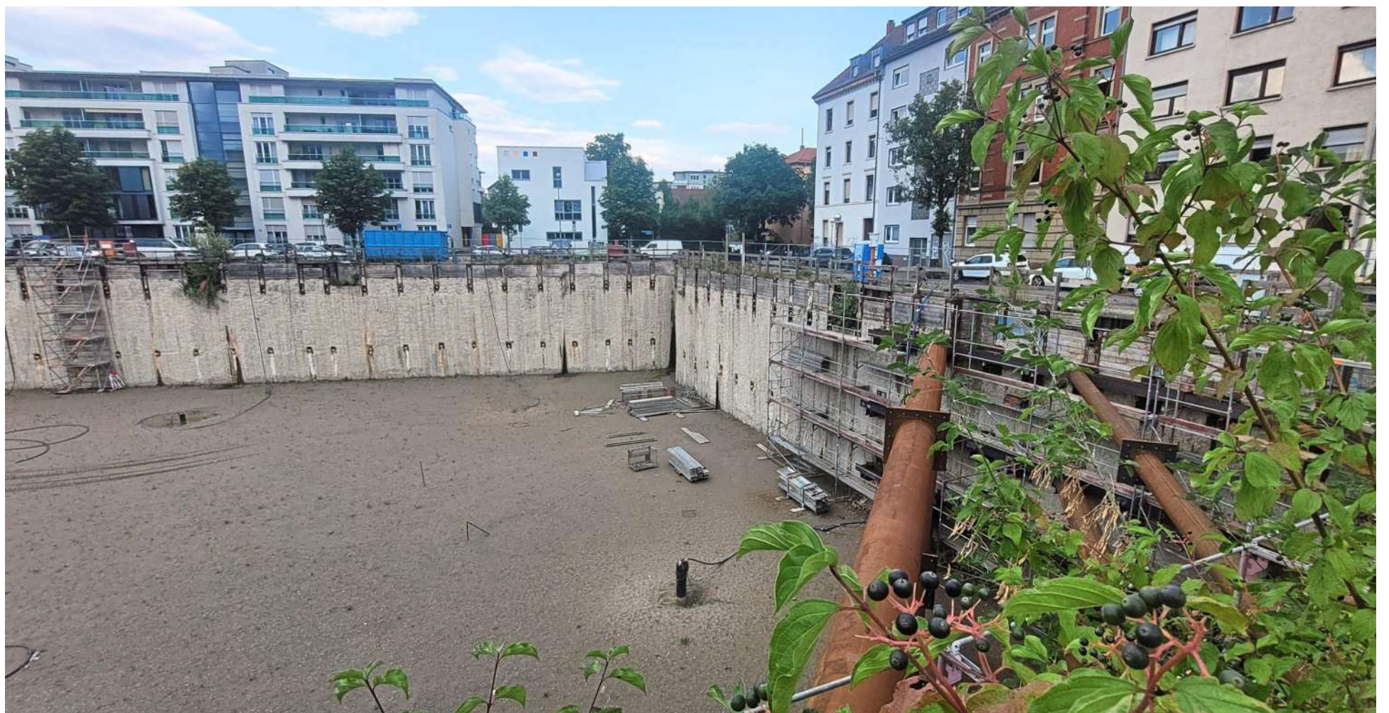
Was geschieht mit der Baugrube für das Projekt „Kwartier“ in der Karlsruher Südstadt? Die Stadt hat zu dem Vorhaben jüngst eine Ausschreibung veröffentlicht, in der die Verfüllung der Grube beschrieben ist. Auf Nachfrage der Redaktion heißt es, die Maßnahme erfolge aus Vorsorge. Ein Rettungsanker könnte sein: der Verkauf der Grube. Foto: Holger Keller
